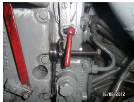
รูปหลังการติดตั้งอุปกรณ์
