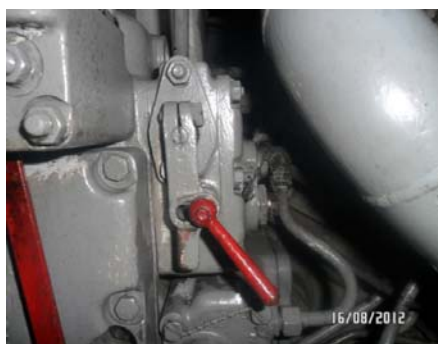
รูปก่อนติดตั้งอุปกรณ์
